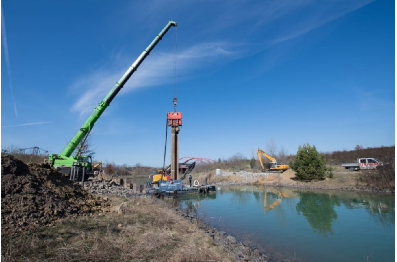
Setzen der 1. Spundwand am oberen Querbauwerk durch Mitarbeiter der Firma STRABAG
