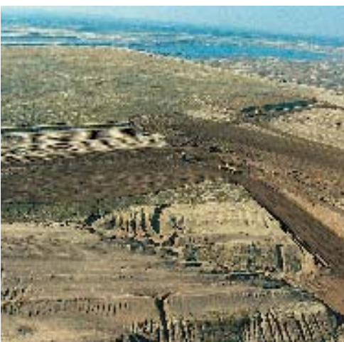
Sicherungsarbeiten auf der Innenkippe
