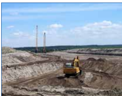
Bau des Kanals in Richtung Sedlitzer See, 2012
