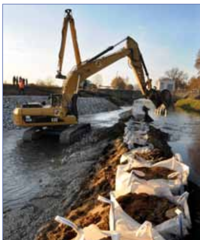
Verlegung der Schwarzen Elster in das neue Flussbett am 29. November 2011
