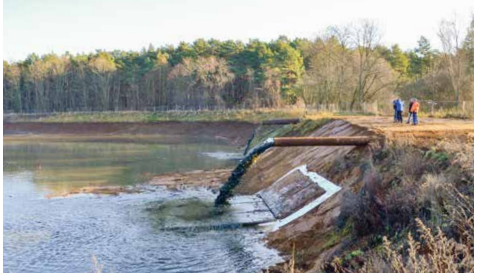
Erfolgreiche Funktionsprobe für das Wiederbefüllen des Sedimentationsbeckens II
