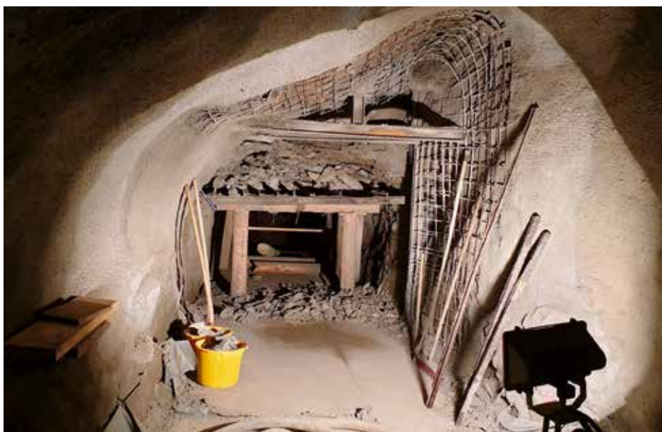
Hergestellter Endausbau in Blickrichtung zum Schlüsselstollen.
