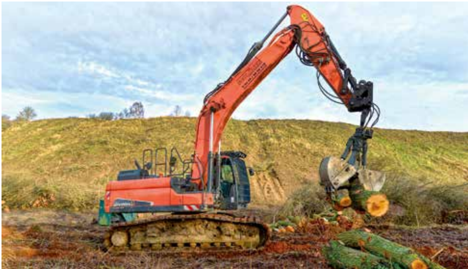
Vorbereitende Arbeiten für die Sicherung der Kippenböschung des Tagebaus Wulfersdorf
