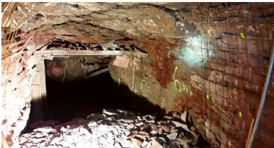
Berauben der Firste im Schlüsselstollen Freieslebenschacht.
