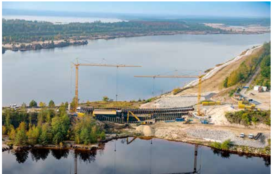
Böschungs- und Kippensicherung sowie Überleiterbau – Große Herausforderungen für den neuen Geschäftsführer (im Bild: Errichtung der Fundamente für die Brücke über den künftigen Überleiter 3)
