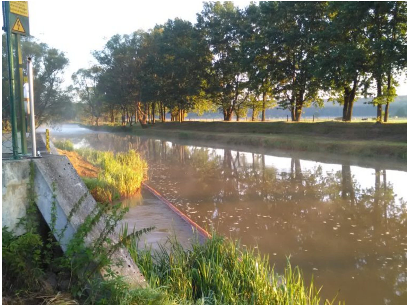
Symbolfoto: LMBV-Abnahmebauwerk an der Spree bei Spreewitz
