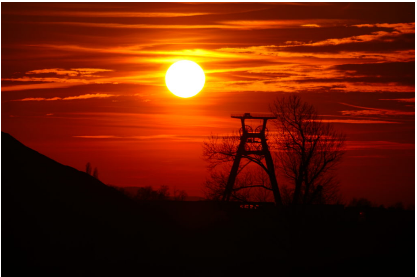
Doppelbock-Fördergerüst – Foto: D. Bodenstab
