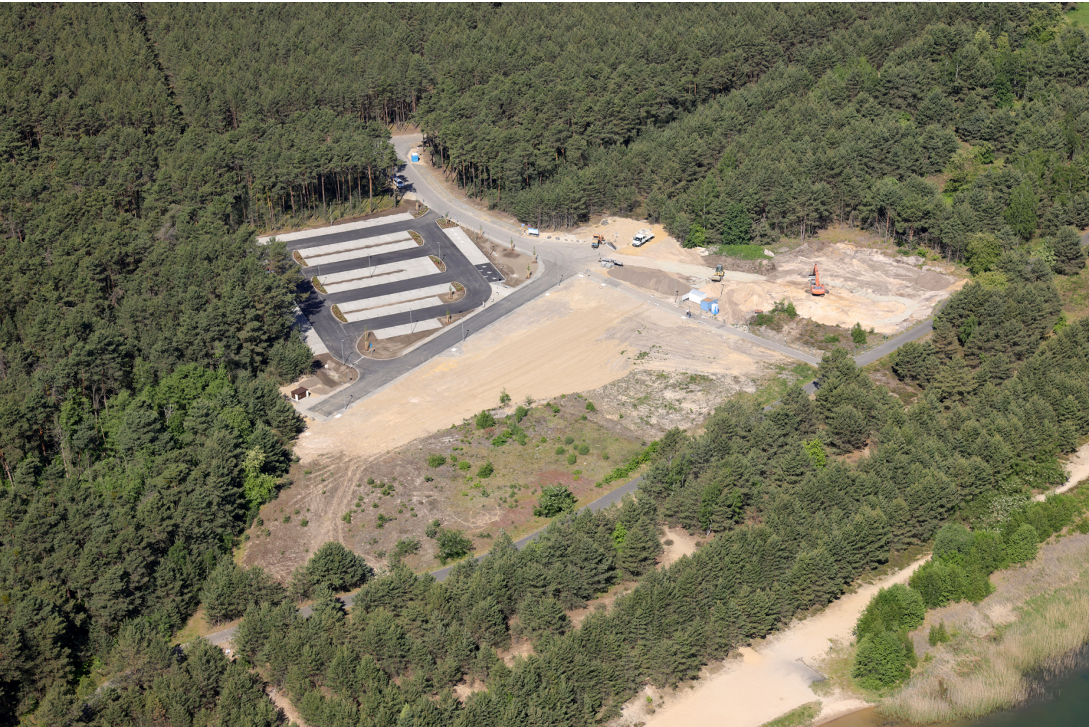
Blick auf den entstehenden Spielplatz am Scheibe-See
