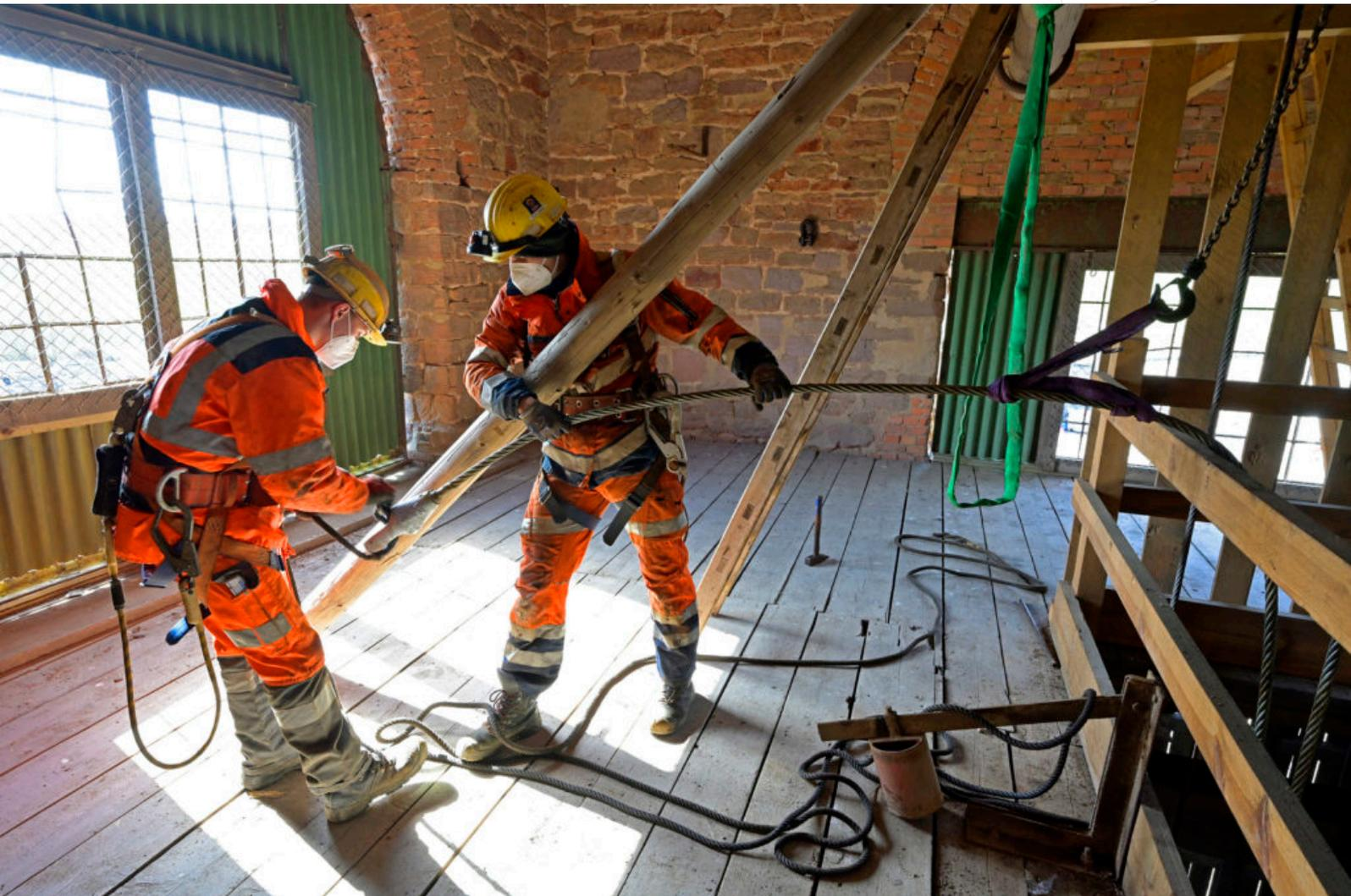
Erneuerung der Führungsseile auf der Schachtanlage Freieslebenschacht 2 der LMBV, Sparte Kali-Spat-Erz, KSE, in Großrörner im ehemaligen Mansfelder Kupferschiefer-Revier. Foto am 22. März 2021.
