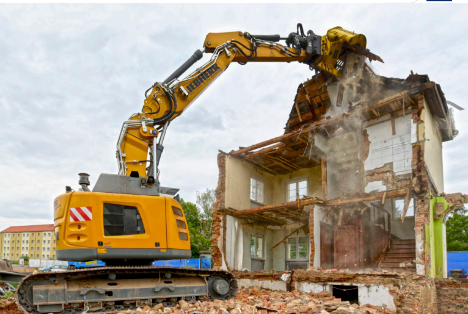
Rückbau von kontaminierten Gebäuden
