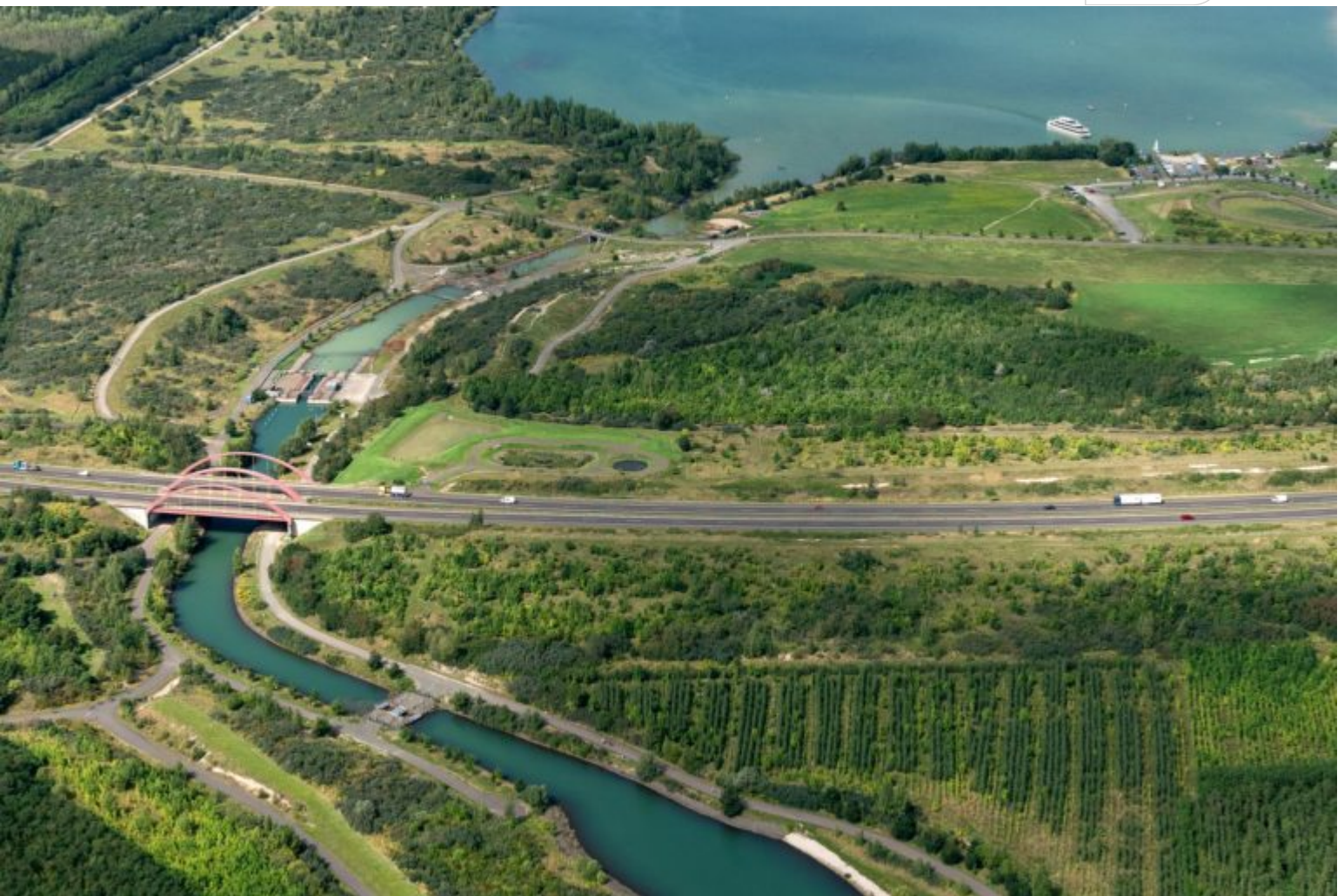
Stoermthaler Kanal mit Fußgängerbrücke, unterem Querbauwerk, Schleuse, Autobahnbrücke und oberem Querbauwerk, 2023 (Foto: Ch. Kortüm)
