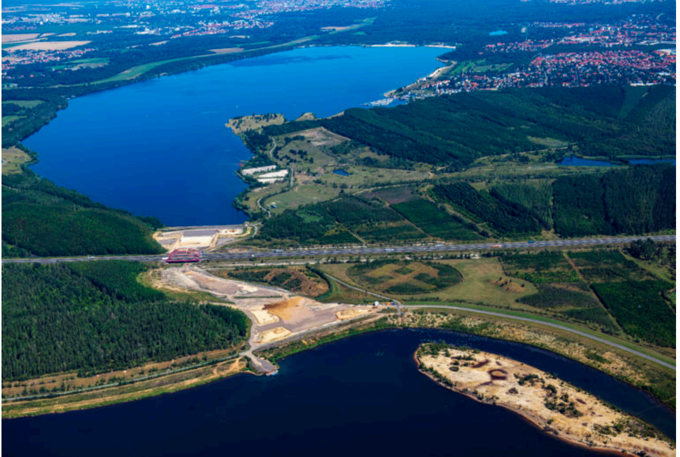
Ruhende Baustelle Harthkanal – Archivfoto v. P. Radke
