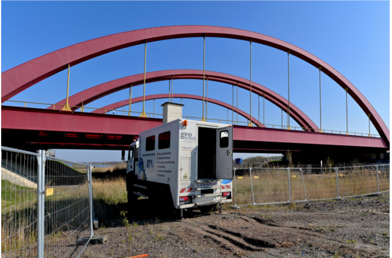
Bodenbeschaffenheitsprüfung durch die Geotechnik Heiligenstadt GmbH auf der Baustelle Harthkanal am Zwenkauer See Foto aus 2019 | C. Bedeschinski
