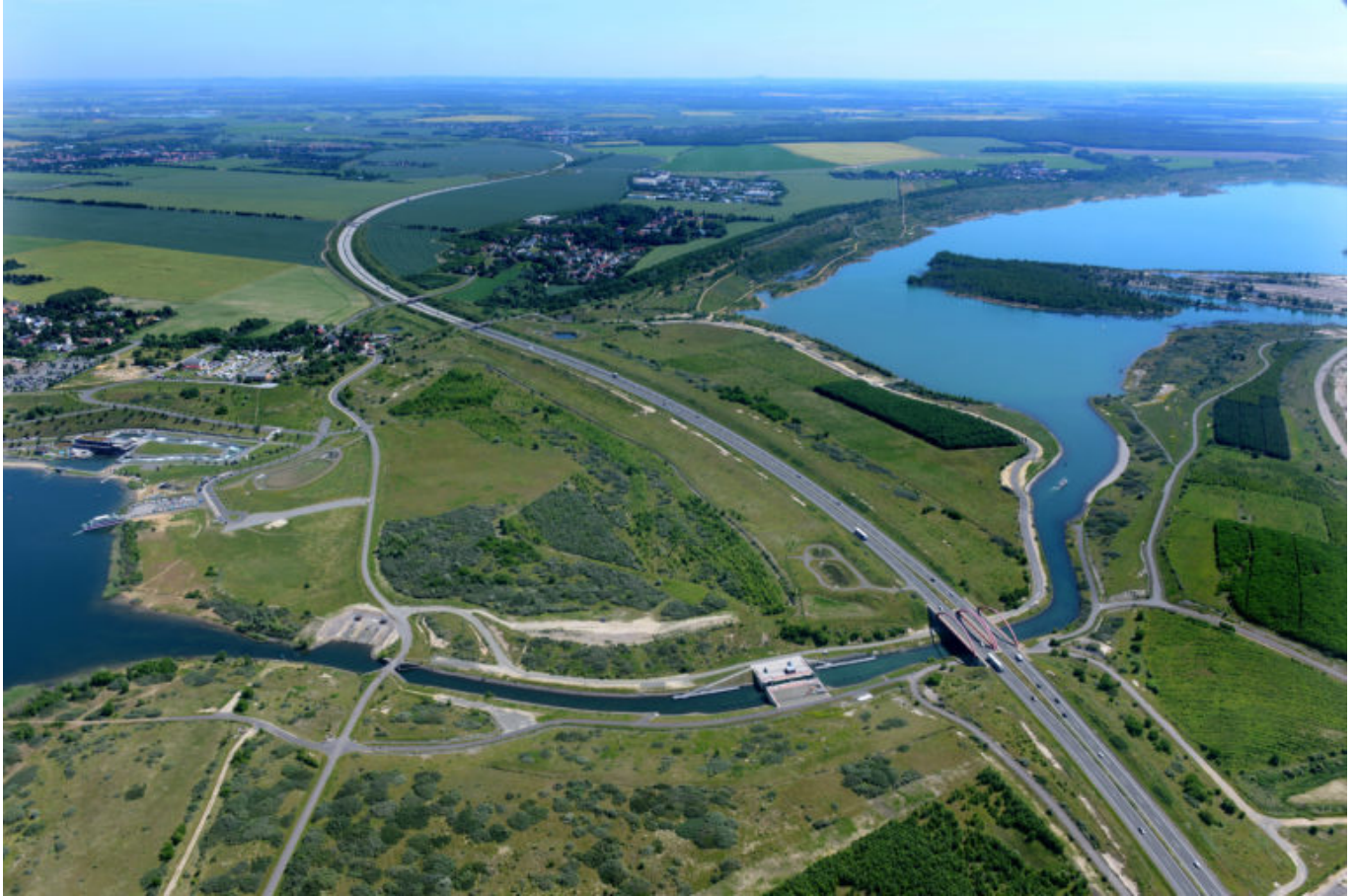
Archiv-Foto der LMBV vom Störmthaler Kanal vor der Sperrung | Peter Radke
