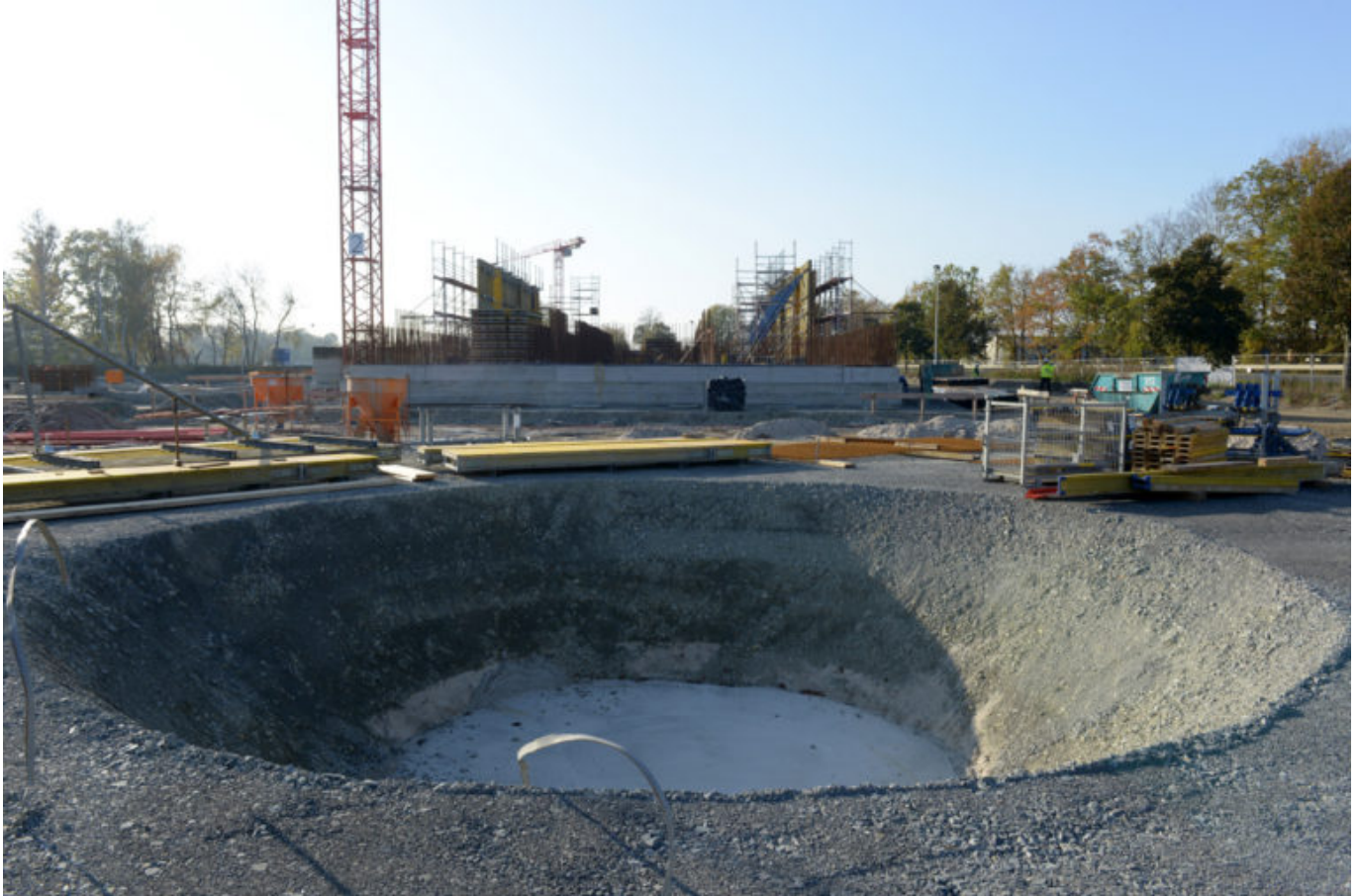
Im Hintergrund des Sedimentationsbeckens entsteht das Maschinenhaus.
