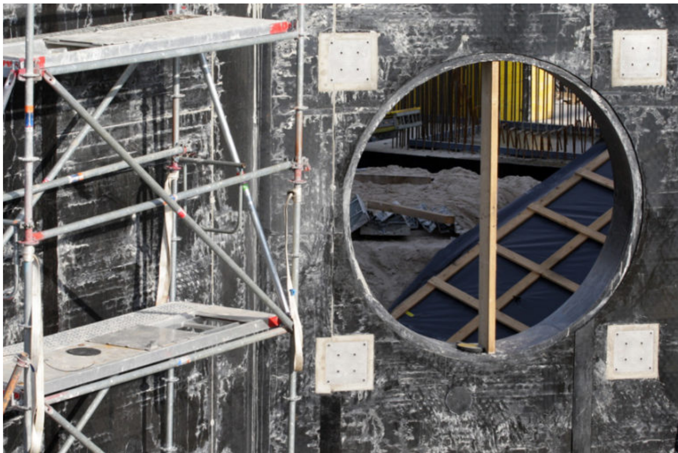
Durchlass für die künftige Rohwasserleitung
