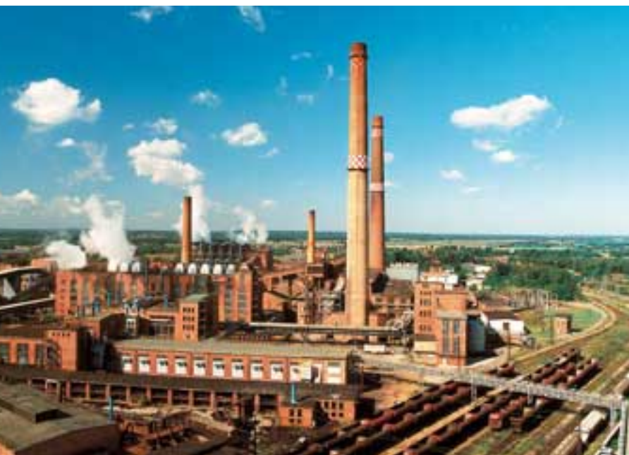
Blick auf den Industriekomplex "Sonne"
