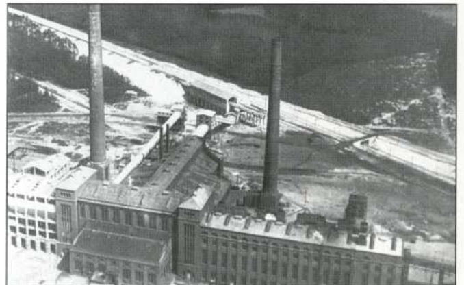
Errichtung der Fabrik III, 1922/23
