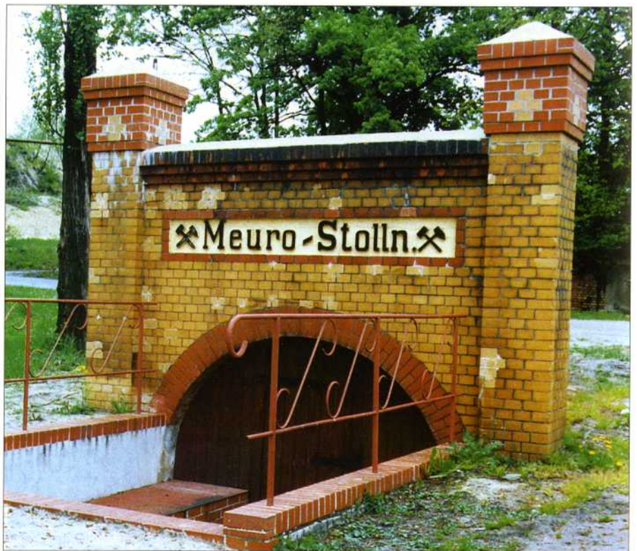
Mundloch des alten Meurostollens
