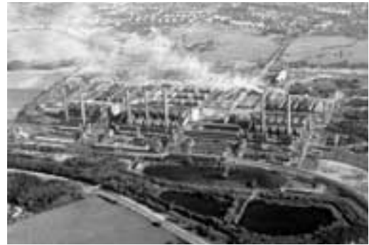
Das Kraftwerk Lützenhain in unmittelbarer Nähe der Tagebaue Seese und Schlabendorf
