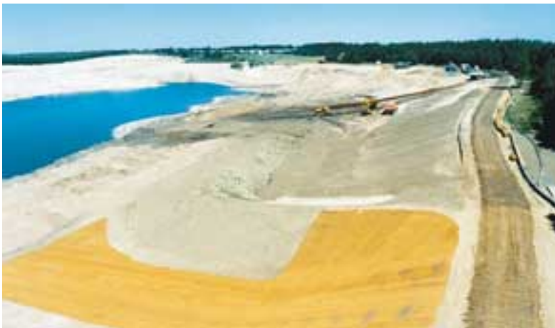
Sanierungsarbeiten am Restloch 12 – dem zukünftigen Drehnaer See
