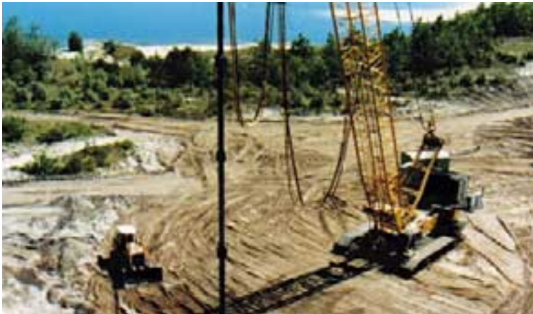
Rütteldruckverdichtung an den Kippenböschungen in Schlabendorf-Süd
