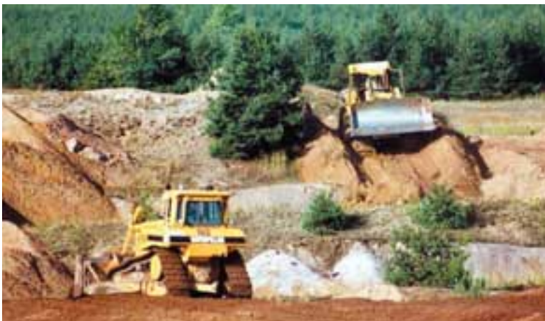
Abflachung der gewachsenen Böschungen im Sanierungsgebiet Seese-West
