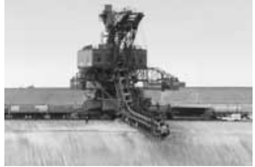
Eimerkettenbagger im Vorschnitt des Tagebaus Seese-Ost
