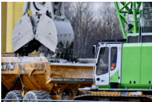
Schlitzwandaushub wird verladen
