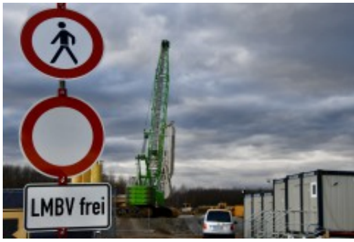
Schlitzwandbaustelle am Zwenkauer See
