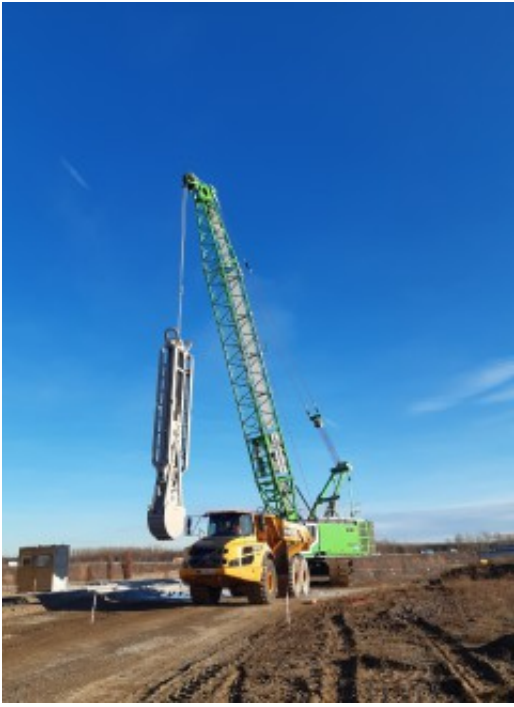
Schlitzwandbaustelle am See-Ufer
