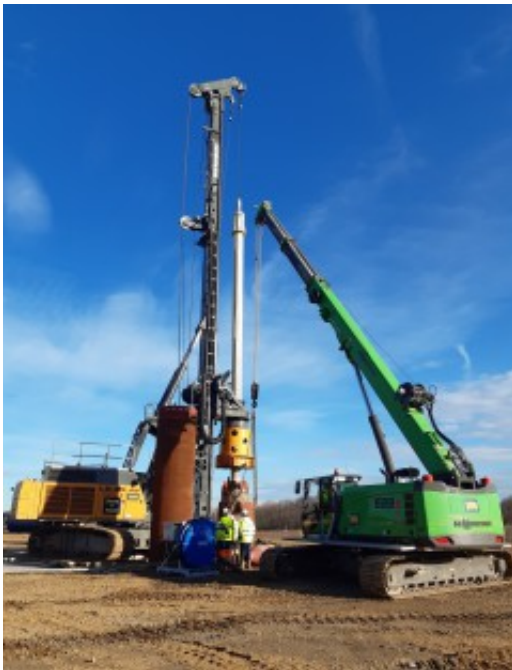
Probepfahlbohrung auf Kippengrund
