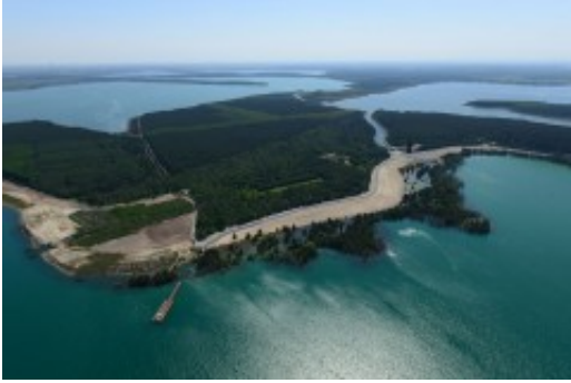
LMBV-Bergbaufolgesee: Sedlitzer See
