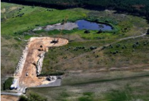
Verdichtung von Instabilitäten
