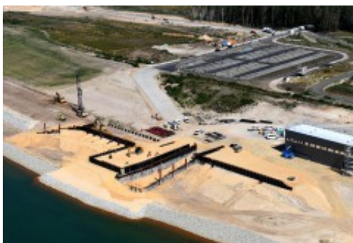
Sanierungsstützpunkt im Bau
