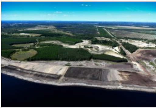
Böschungssicherung RL Meuro
