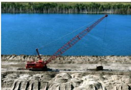
Seilbagger am Ufer des Klinger Sees
