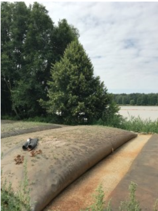
Geotubes an Vorsperre LfU-Test
