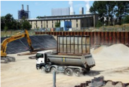
BAUER-remediation project Schwarze Pumpe
