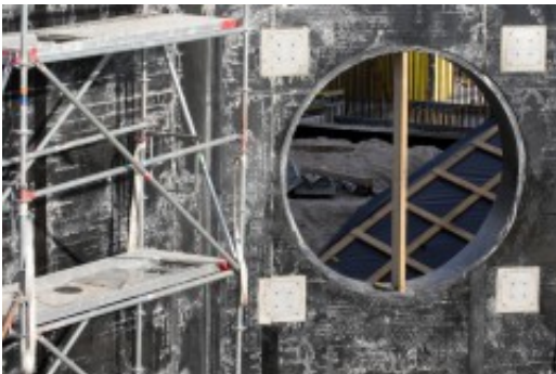
Durchlass für die künftige Rohwasserleitung
