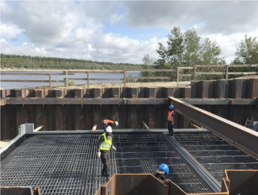
STRABAG im südlichen Spundwandkasten
