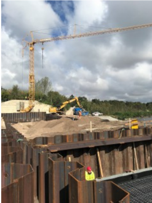
N-Blick an der Überleiter-Baustelle
