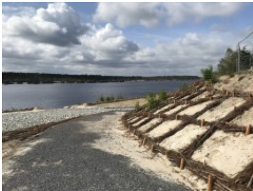
Gestaltete Böschung zum Blunoer Südsee
