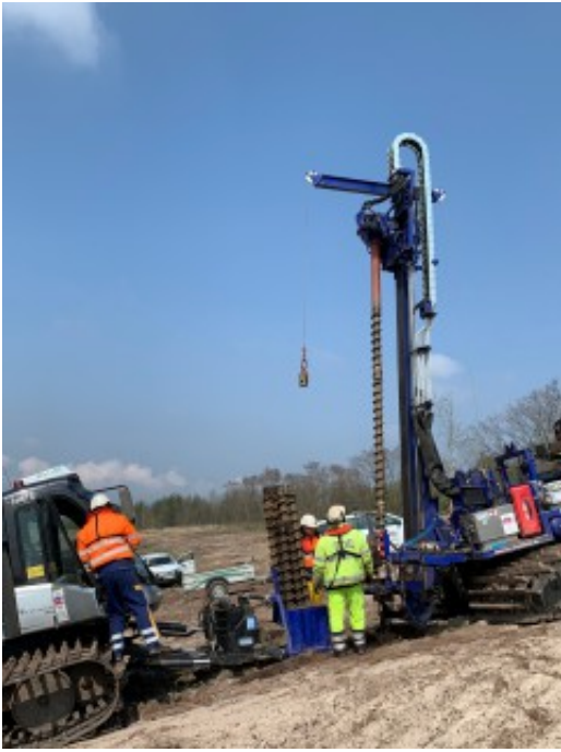
TDE-Bohrgerät im Einsatz
