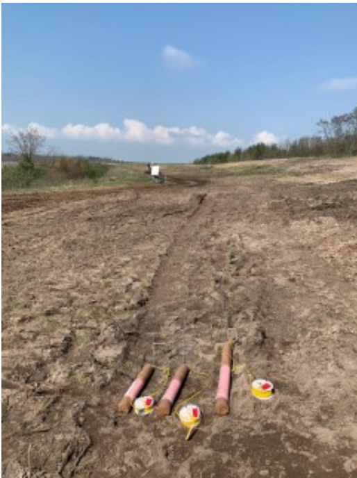
Dreier-Sprengladung - vorbereitet für ein Bohrloch
