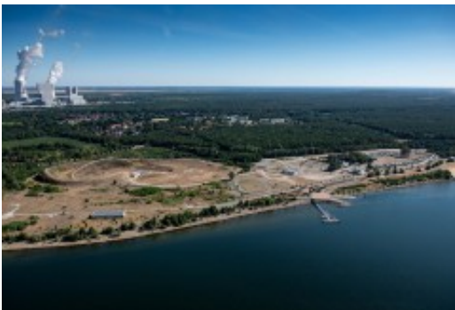
Boxberger Steganlage am Bärwalder See
