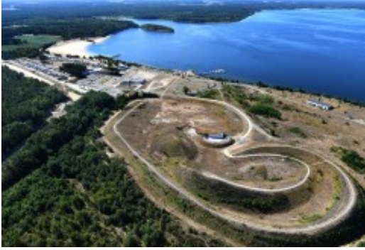
Landschaftsbauwerk OHR am See
