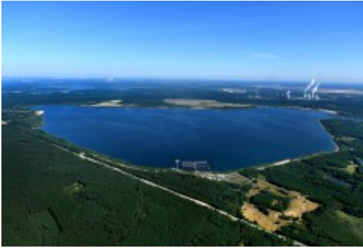
Bärwalder See aus der Luft
