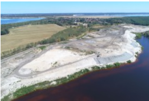
Sanierungsarbeiten am Sedlitzer Ufer
