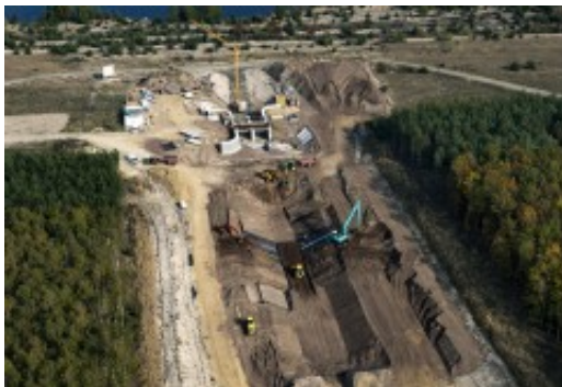
Bau der Auslaufbauwerkes
