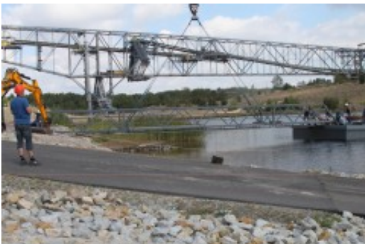
Vollbracht - Der Steg kann montiert werden
