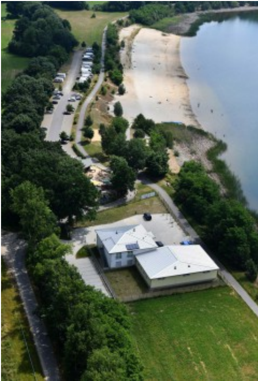
LMBV: Blick über die auf Kippenflächen angelegten Lohsaer Fischteiche - wegen Gefahren noch Sperrbereich
