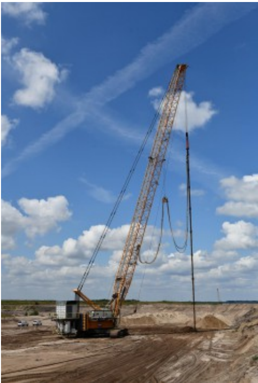
Rütteldruckverdichtung am LMBV-Abschnitt Tgb.
