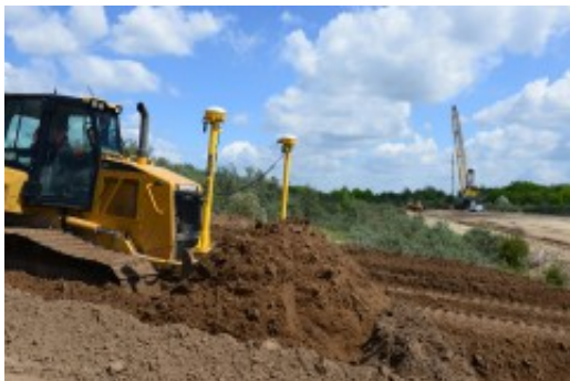
Planierarbeiten am Böschungssystem
