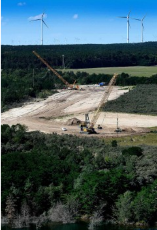
Rütteldruckverdichtung am Restloch Greifenhain (künftiger Altdöberner See)
