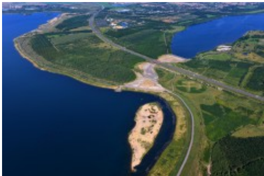
LMBV: Baustelle Harthkanal 2017 - A 38
