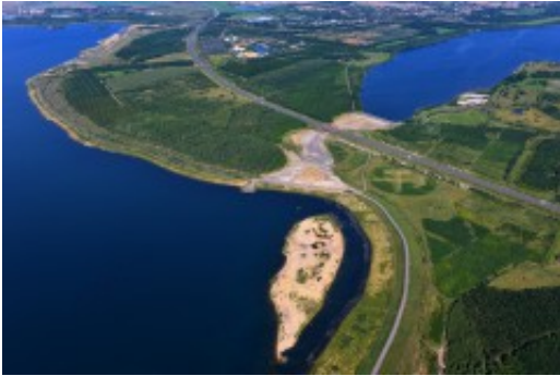
LMBV: Baustelle Harthkanal 2017 - A 38
