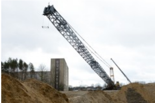
Der 80 m lange Ausleger ist montiert
