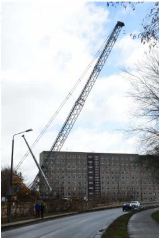
Probeaufrichten des Auslegers
