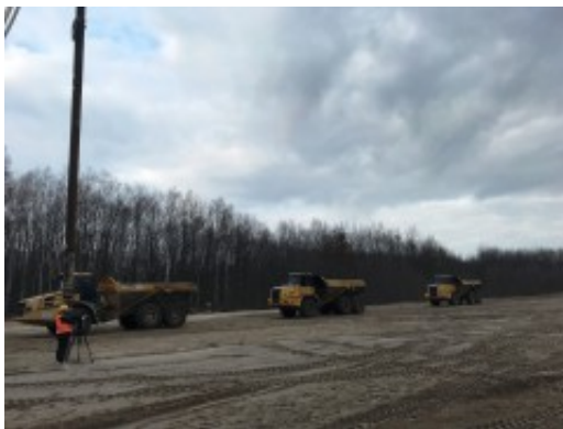
Sedlitzer See - RDV-Baustelle
