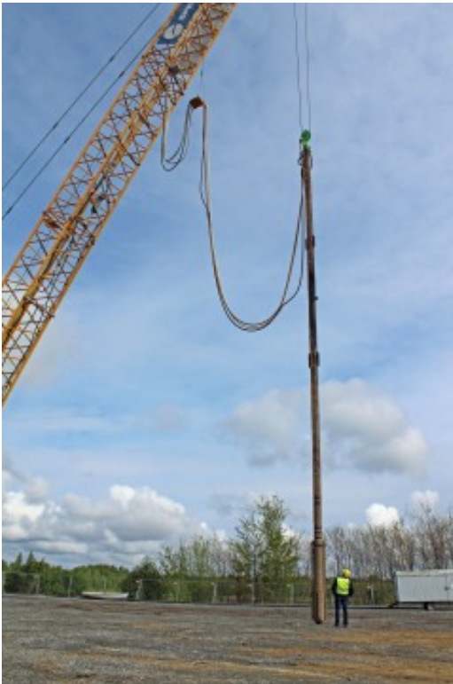
Rüttellanze eines Rüttelbaggers am Kuthteich
