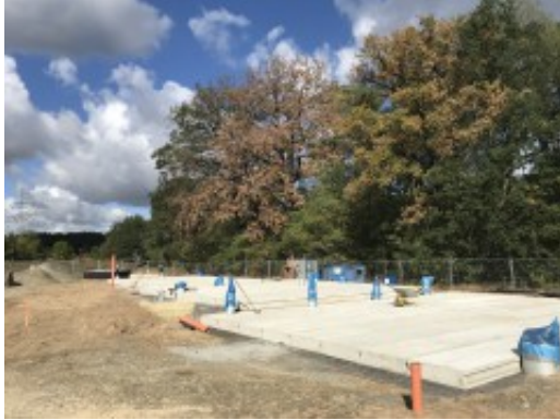
MWBA Neustadt (Spree) steht bereits
