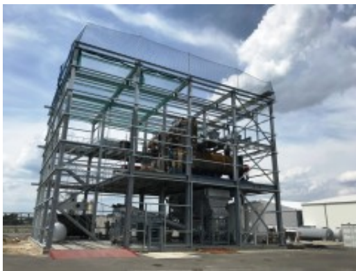
LMBV: Gerüst der VTRA-Anlage
