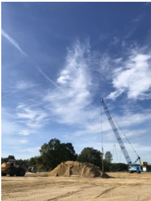
Verdichtungsarbeiten bei Groß Särchen
