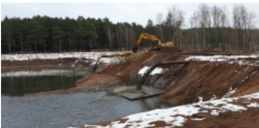
Das Sedimentationsbecken II füllt sich mit dem Sauggut
