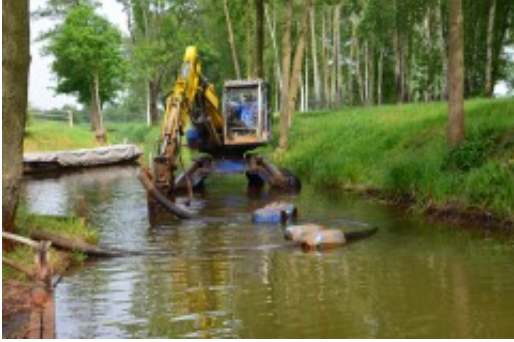
• Entschlammung der Wudritz - Befüllen von Geotubes mit EHS zum Abtrocknen an der Ragower Kahnfahrt
