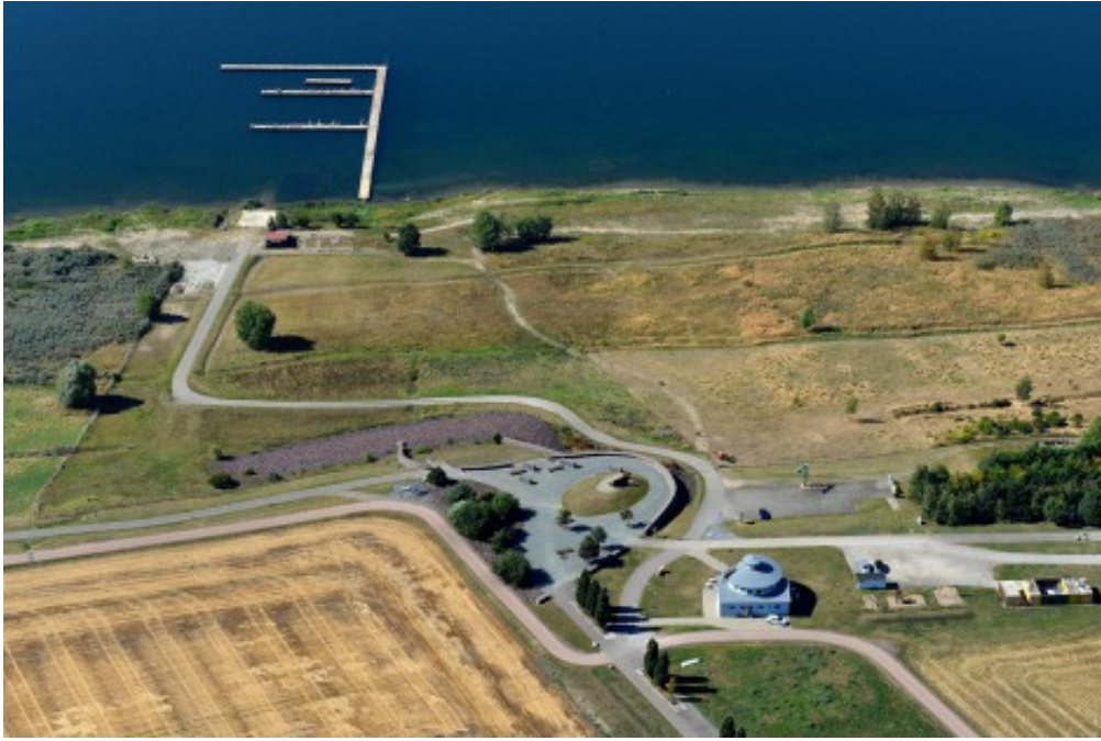
Bergbaufolgelandschaft: Schadelebener Ufer am Concordiasee
