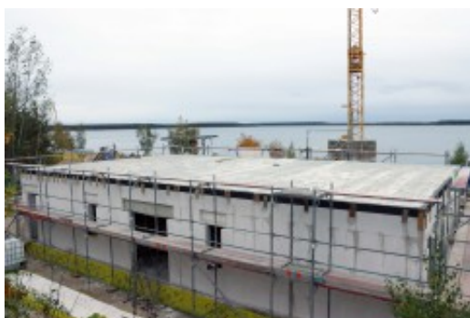
Der Rohbau des neuen Multifunktionsgebäudes •
