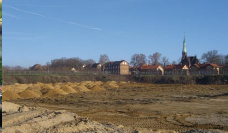
Verfüllung des Restloches 4, im Hintergrund: die Glaswerksiedlung
