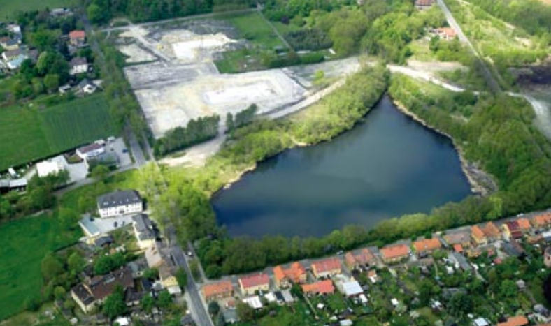
Restloch 4 bei Annahütte vor Sanierung
