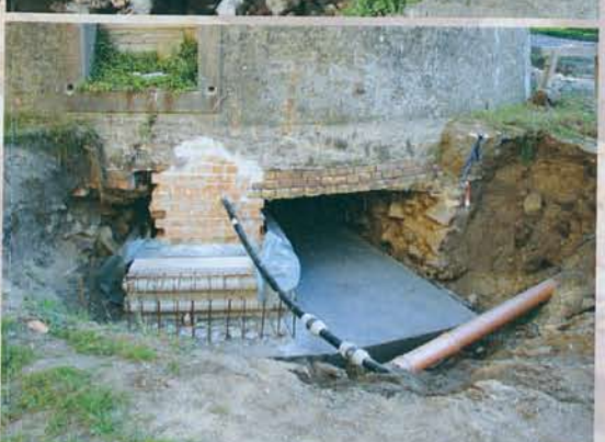
Seitlich folgenden Unterfangungsabschnitt mit Sauberkeitsschicht Betonausgleichsschicht
