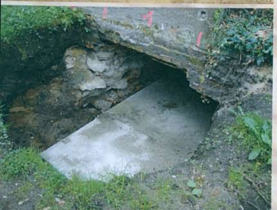
Betonausgleichsschicht
