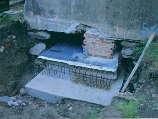
Abdichtung wird überlappend verschweißt
