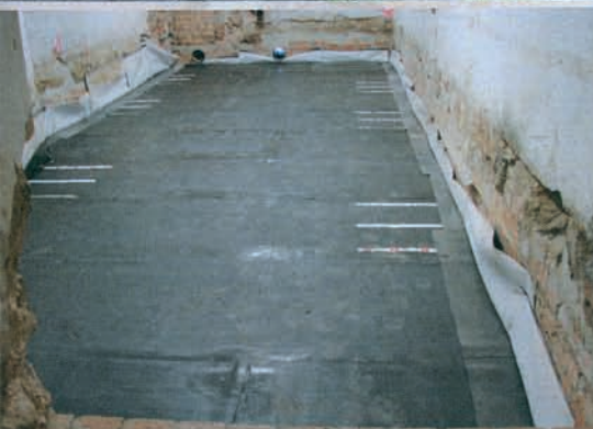
Abdichtung vollflächig verlegt
