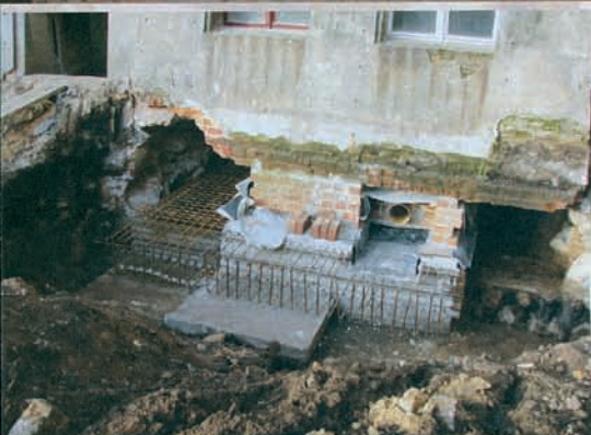
Unterfangungsabschnitte werden im Taktverfahren bearbeitet
