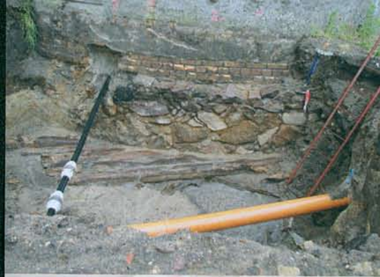
Freigelegter Unterfangungsabschnitt mit Holzrost
