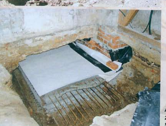
Abdichtung liegt zwischen zwei Schutzvliesen
