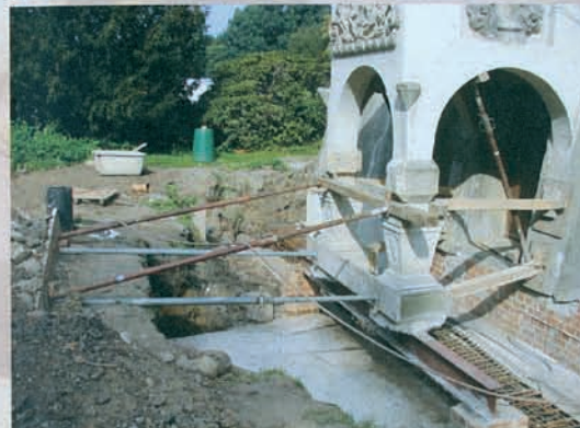
Temporäre Abfangung des kleinen Portikus am westlichen Seitenflügel
