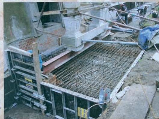
Unterfangungsabschnitte werden im Taktverfahren bearbeitet
