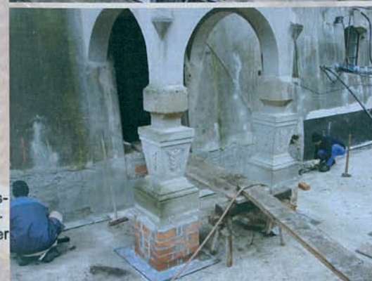
Kraftschluss zwischen Pfeilern des Portikus und Unterfangung ist hergestellt
