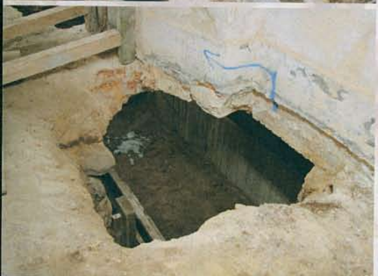
Stützschalung für die Betonausgleichsschicht
