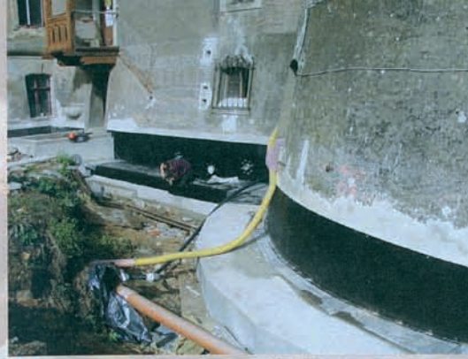
Äußerer Anschluss zwischen horizontaler und vertikaler Abdichtung
