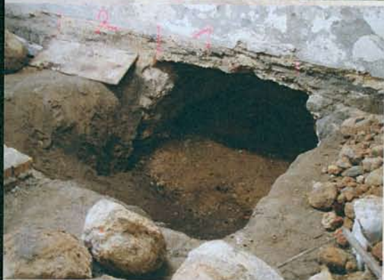
Ausgeschachteter Fundamentabschnitt
