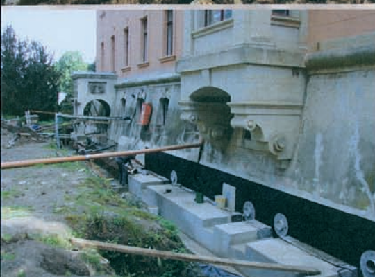
Ringbalken mit Ausparungen für Hausanschlüsse, darüber Vertikalabdichtung bis OK Gelände
