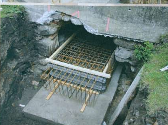
Fertiggestellte Bewehrung für Betonierabschnitt, Anschlussbewehrung hochgebogen
