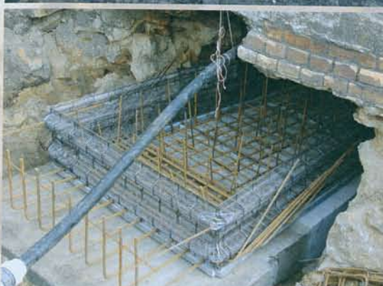
Einflechten der Bewehrung
