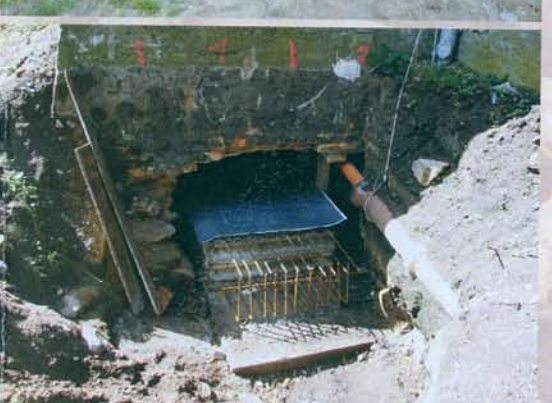
Zuschnitt der horizontalen Abdichtung
