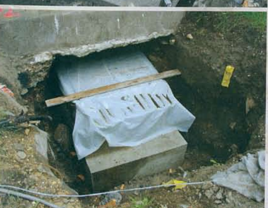
Betonausgleichsschicht
