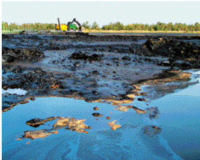
Seit etwa sechs Jahren geht es der Deponie Zerre an den Kragen. Insgesamt sind hier mehr als 250000 Tonnen Teerölfeststoffe zu entsorgen.
