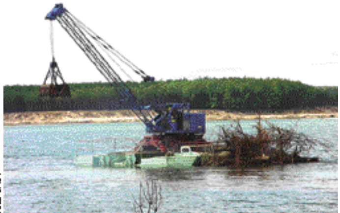
Ein auf Pontons montierter Bagger birgt Totholz aus dem See.
