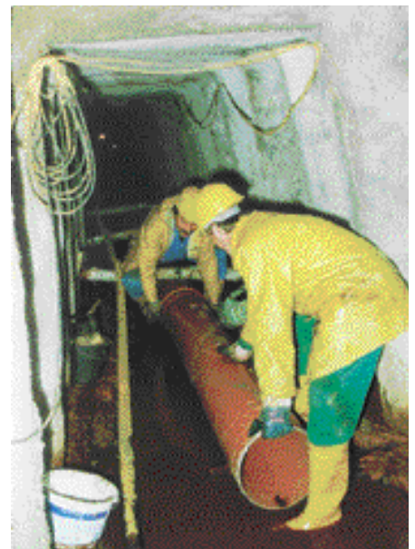
Mit Kraft und Fingerspitzengefühl werden Entwässerungsleitungen unter Tage verlegt.
