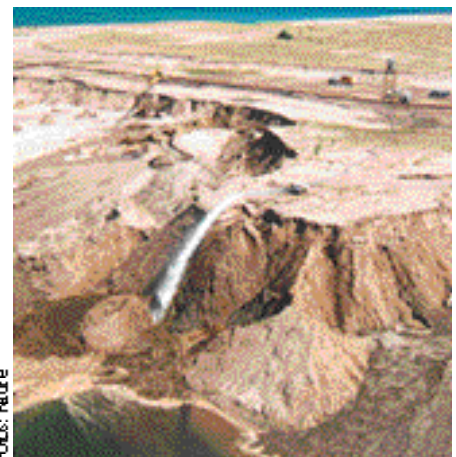
Die Insel im 470 Hektar großen Gräbendorfer See wird gesichert: Kräftige Wasserstrahlen flachen die steilen Böschungen ab.
