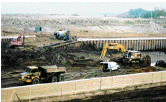
Die Kaimauer steht; jetzt wird das Hafenbecken ausgebaggert und gestaltet. Foto: Radite
