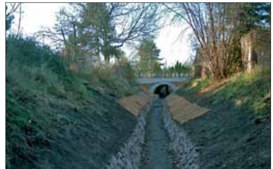
Der ausgebaut Zschampert mit der neuen Straßenbrücke
