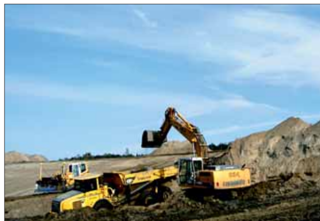
Böschungsabflachung im ufernahen Bereich des künftigen Ilse-Sees
