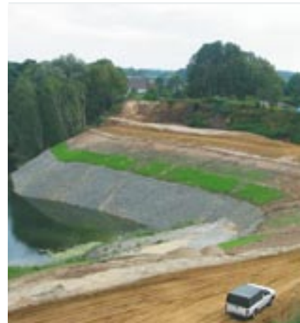
Sanierte Uferböschung am Restloch Spora
