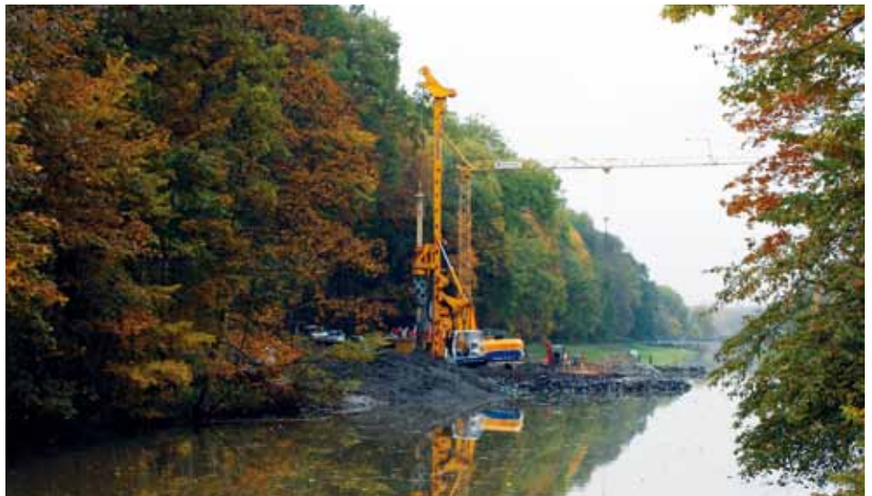
Die Baustelle am Connewitzer Wehr im Spätherbst 2009 vor der frostbedingten Winterpause.
