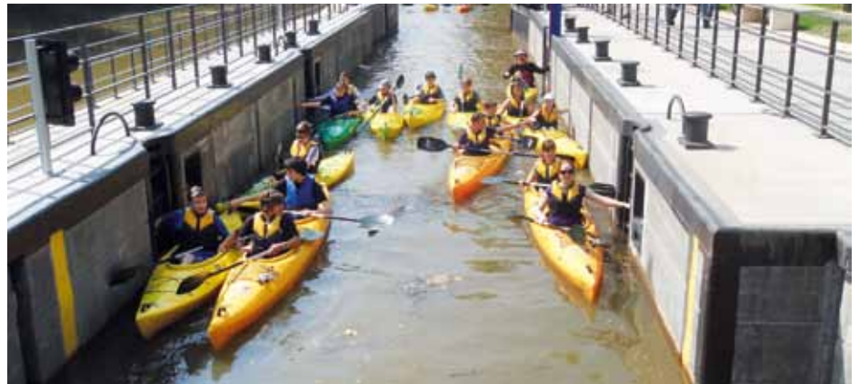
In der 17 x 4,50 Meter großen Schleusenammer am Connewitzer Wehr mit einer Hubhöhe von 1,80 Meter finden zahlreiche Paddler und künftige Wasserwanderer Platz.
