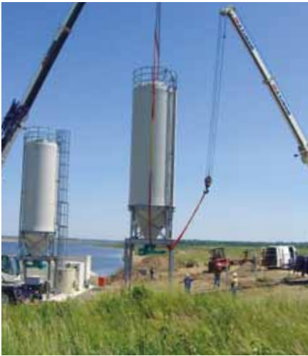
Aufgebaut wurden zwei Silos, die jeweils eine Lagerkapazität von 50 Tonnen Branntkalk haben.
