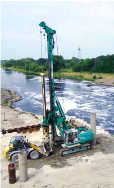
Bau der Fischtreppe wird fortgesetzt.
