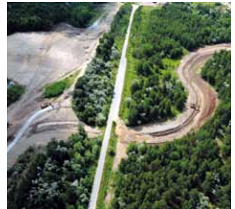
Bau des Ableiters aus der Vogelperspektive.
