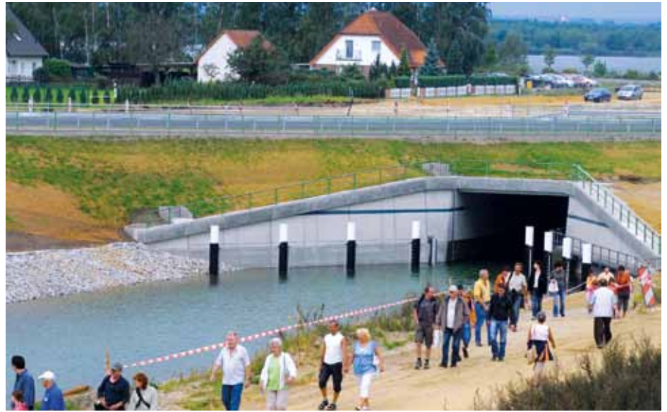
Großes Interesse bei der Baustellenbesichtigung am Überleiter 12 im Lausitzer Seenland.
